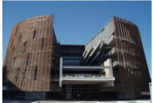
Foto: Parc de Recerca Biomèdica de Barcelona (PRBB)
